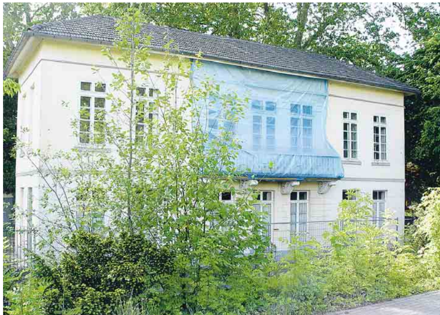
Das ehemalige Bahnhofsgelände soll zu einem Kultur-Zentrum umgewandelt werden, wünschen sich engagierte Bürger.
